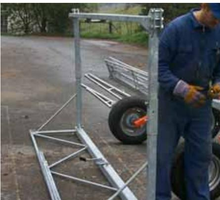
15. Der Pendelmittelteil wird aus dem Ober und Unterteil zusammengefügt, mit den Versteifungstreben ergänzt und verschraubt.
