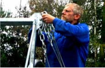
18. Die Seile werden mit den Kettengliedern am Pendelmittelteil befestigt. Die Kettenglieder dienen dabei als Ausgleich für fertigungsbedingte Längentoleranz der Seile. Die Reihenfolge der Seile wird in nachstehender Skizze gezeigt.
