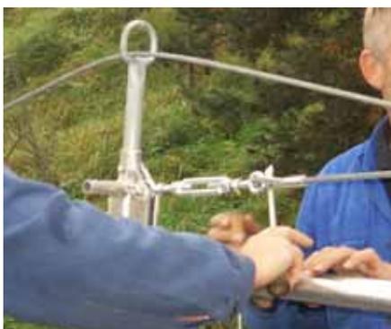
26. Mit den sich auf der Rohrseite befindlichen Spannschlössern können die Auslegerrohre justiert werden.
