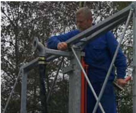
16. Mit dem waagrechten Windverband nach rückwärts wird der Mittelteil, am Mittelsteher an der oberen Aufnahme, mit dem Bolzen pendelnd aufgehängt. Der Führungsrahmen wird wieder am Pendelmittelteil befestigt.
