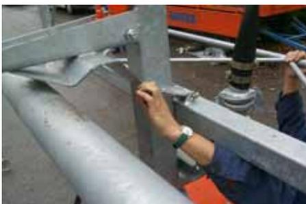
17. Der Arretierungsbügel am Pendelteil wird zum Mittelsteher geklappt. Ein Pendeln wird dadurch vermieden und die Montage erleichtert.
