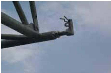
25. Es ist darauf zu achten dass mit den einstellbaren Hakenschrauben eine gerade Linie bei den Auslegerrohren erreicht wird.
