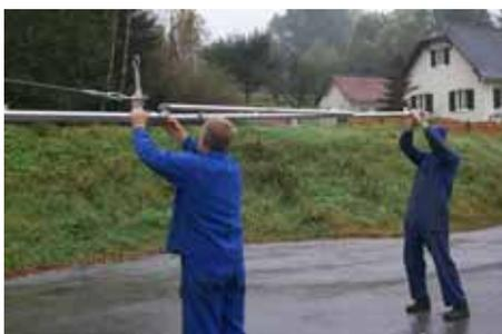
27. Das letzte Auslegerrohr ist nicht klappbar, sondern wird nur eingesteckt, beim Windverband eingehakt und angekuppelt, sowie mit Seil Nr. 6 verbunden.
